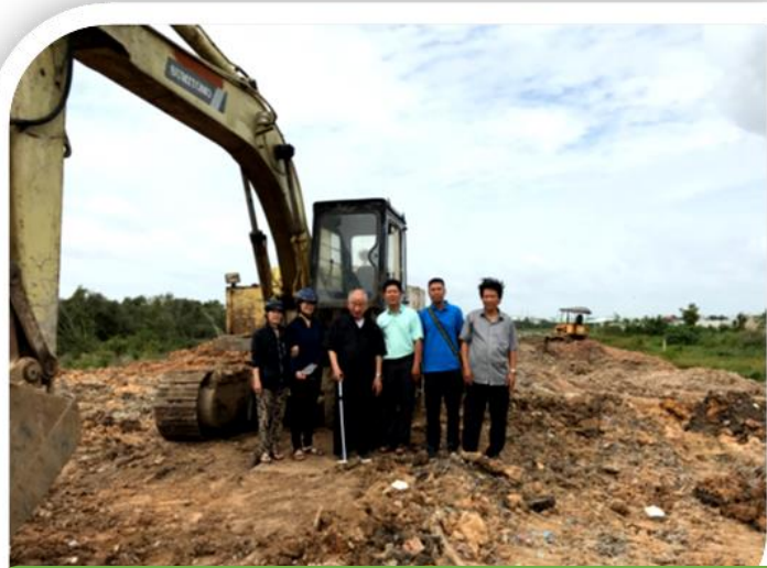
Mảnh đất 5.000 m 2 đang san lấp để xây dựng Nhà Mẹ và Tập Viện của Hiệp Hội – Vĩnh Lộc B
